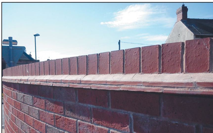
Рис. 226 Кровельная плитка, уложенная в два ряда.
