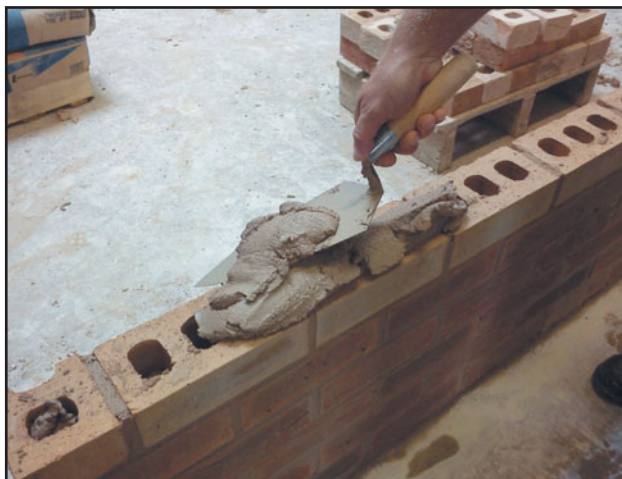
Рис. 112 Добавление раствора к исходной линии строительного раствора.
