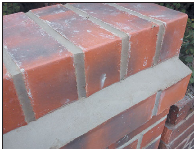
Рис. 233 Законченный отлив из строительного раствора.
