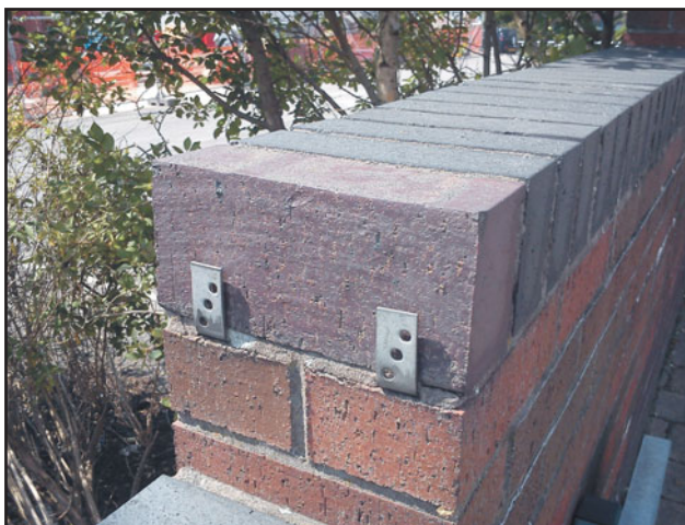
Рис. 209 Простой гребень стены из уложенных на ребро кирпичей: крайний кирпич удерживается на месте с помощью оцинкованных скоб.
