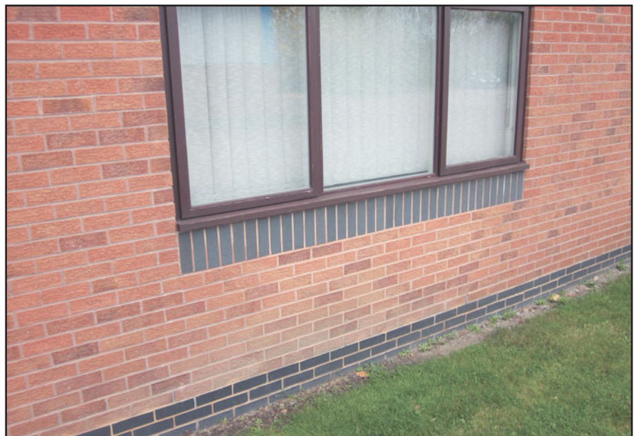
Рис. 256 Кладка из установленных на торец кирпичей под оконным проемом на уровне подоконника.
