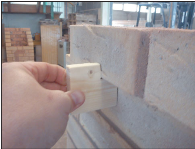
Рис. 219 Контроль величины выступа с помощью куска дерева с вырезом.
