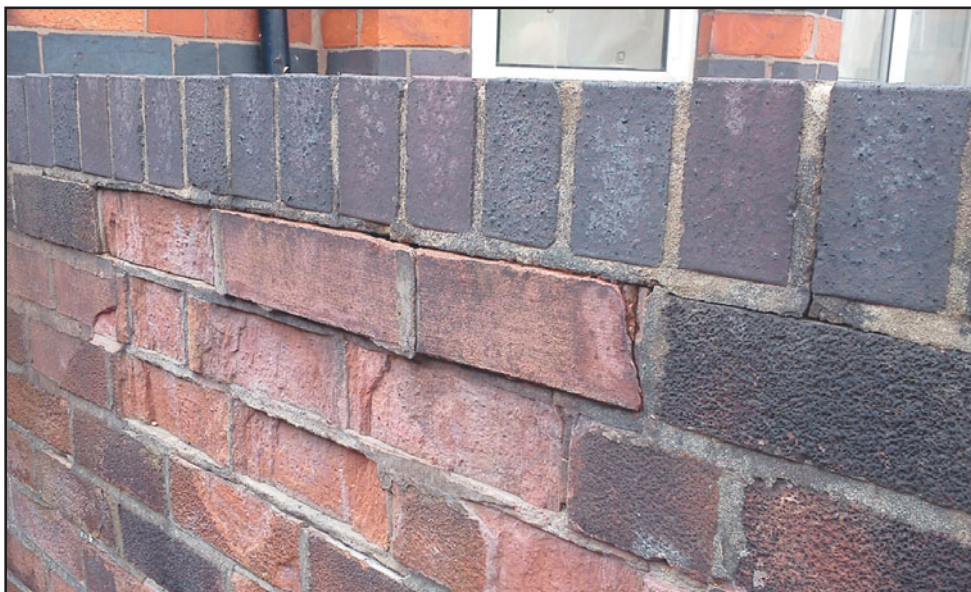
Рис. 218 Гребень стены, выложенный поверх пояса.
