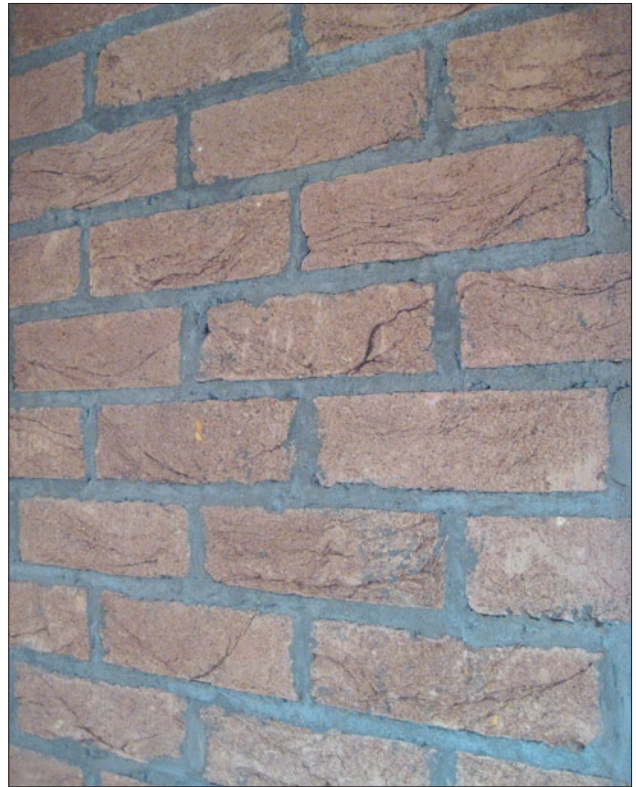
Рис. 163 Выполнение шва вподрезку.
