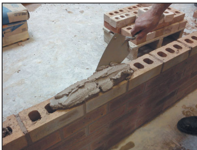
Рис. 111 Выкладывание строительного раствора.
