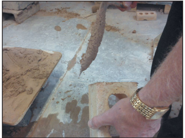
Рис. 117 Подготовка к нанесению раствора для вертикального шва.
