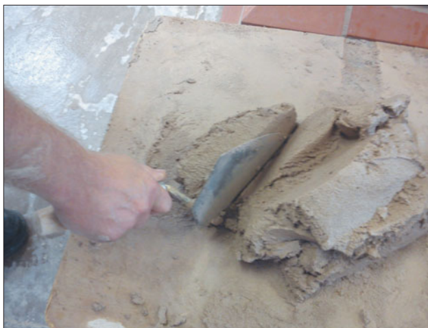
Рис. 107 Отсечение порции строительного раствора.
