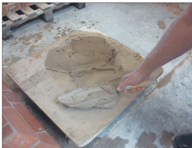
Рис. 110 Подбор строительного раствора кельмой.
