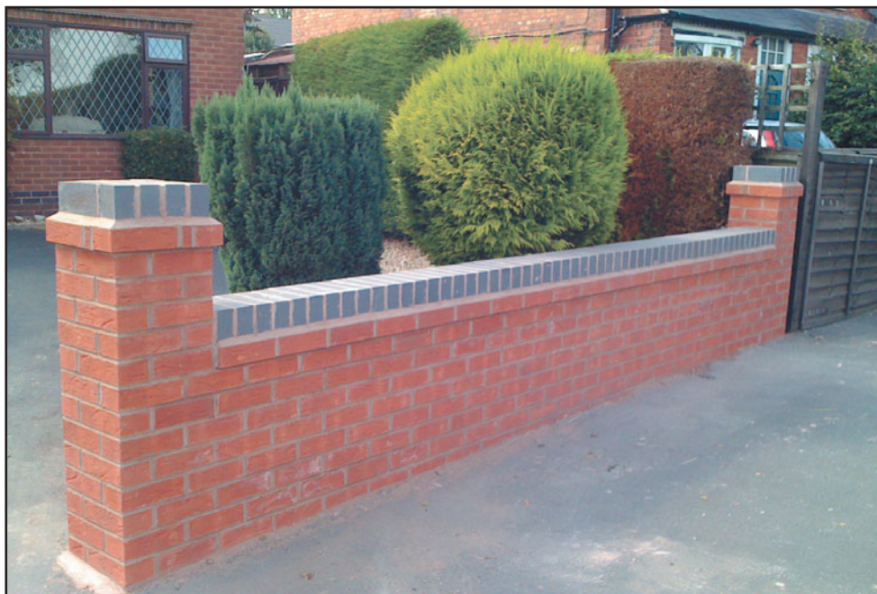
Рис. 218 Гребень стены, выложенный поверх пояса.
