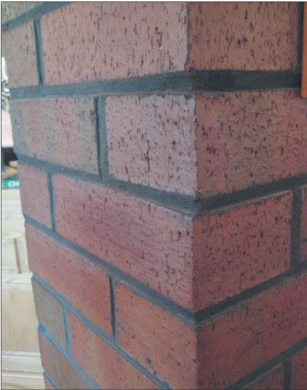
Рис. 162 Выполнение шва кирпичной кладки со скосом книзу.
