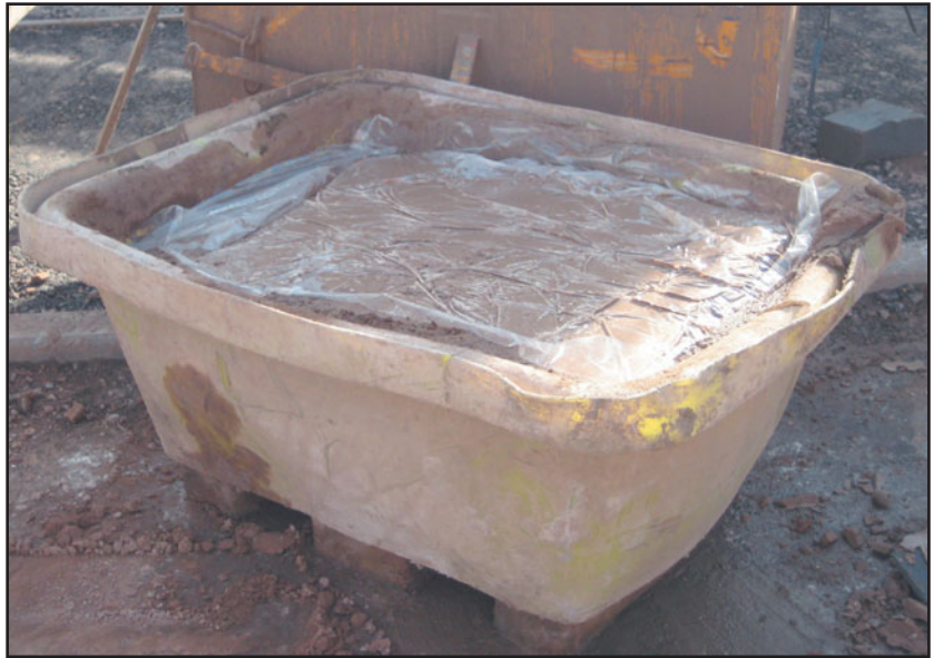
Рис. 24 Готовый раствор, доставляемый на строительный объект.
