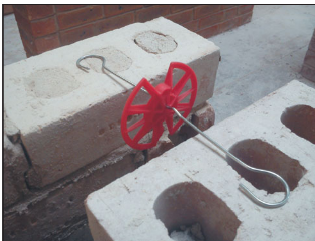
Рис. 176 Пластмассовый фиксатор плит теплоизоляционного материала.
