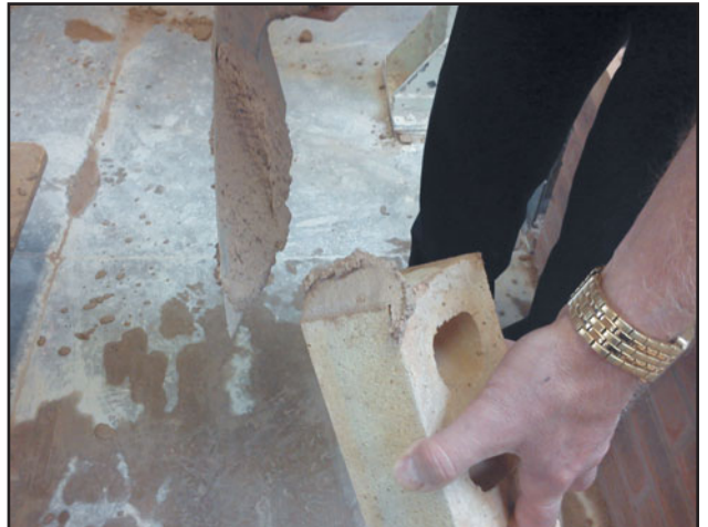
Рис. 118 Нанесение первой части раствора для вертикального шва.
