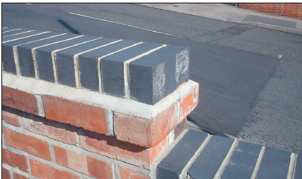
Рис. 223 В торце стены поясок может быть удлинен для обеспечения защиты от атмосферных осадков.
