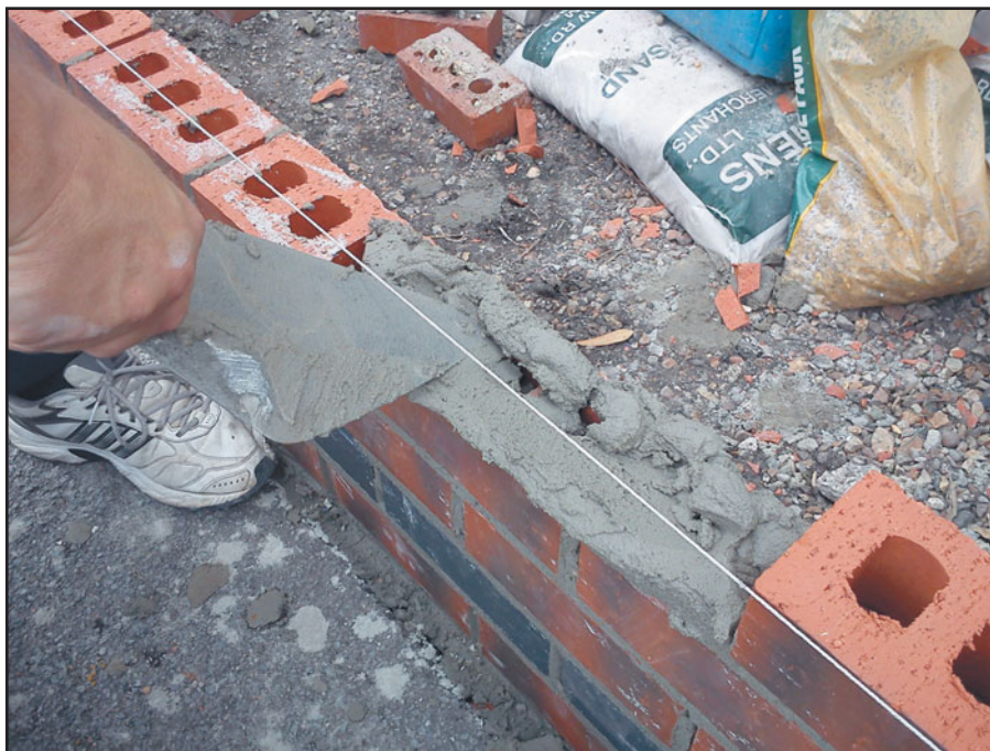
Рис. 140 Расстиление раствора под шнуром-причалкой.
