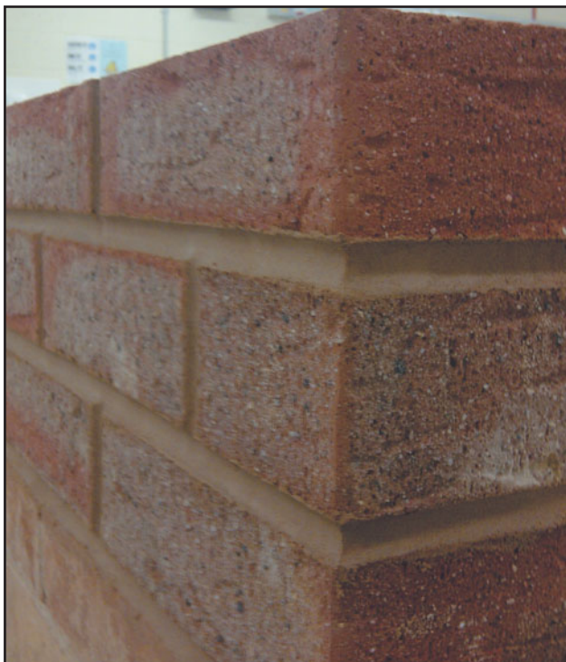
Рис. 164 Правильно выполненный полукруглый шов на наружном углу.
