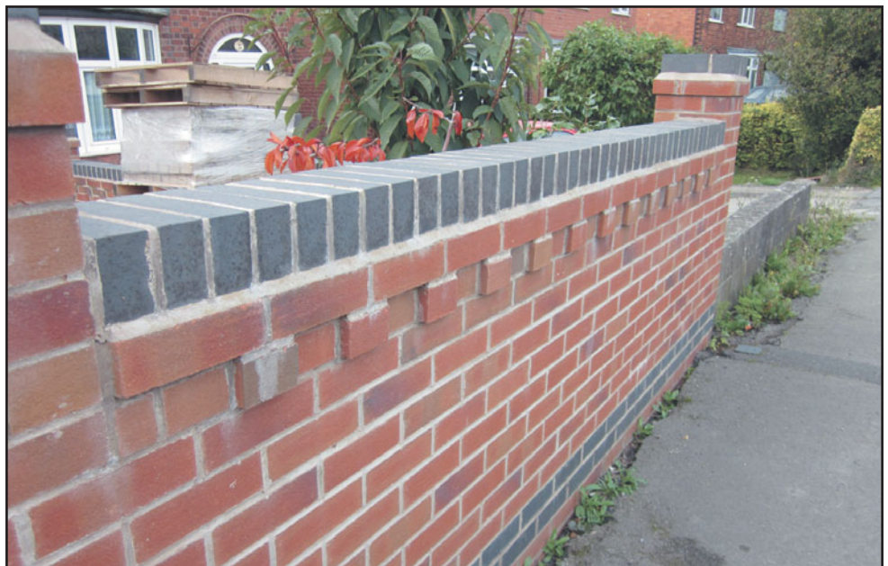
Рис. 252 Ряд кирпичной кладки с отдельными выступающими кирпичами, находящийся непосредственно под пояском; типовое применение — наверху граничной стены.
