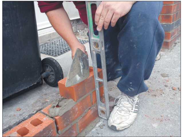
Рис. 129 Важно потратить много времени, чтобы добиться точного выравнивания по вертикали первых трех рядов кирпичей.
