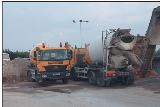
Рис. 13 Автомобили, доставляющие готовую бетонную смесь.
