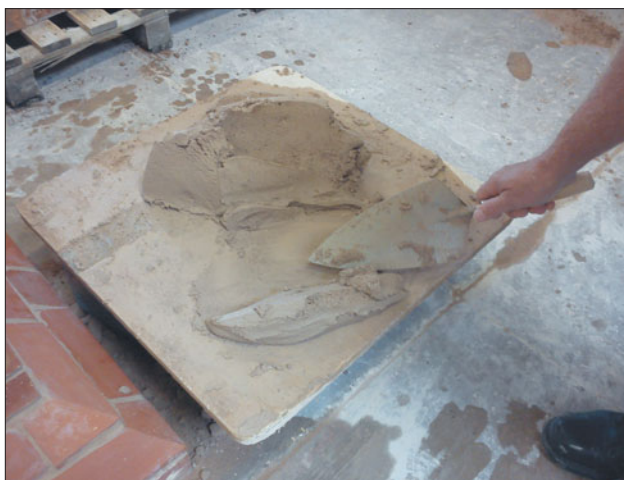
Рис. 109 Подготовка к подбору строительного раствора.
