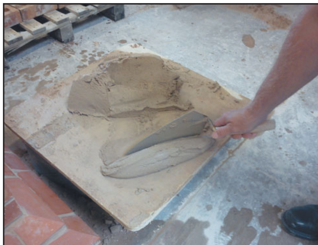
Рис. 108 Раскатывание строительного раствора.
