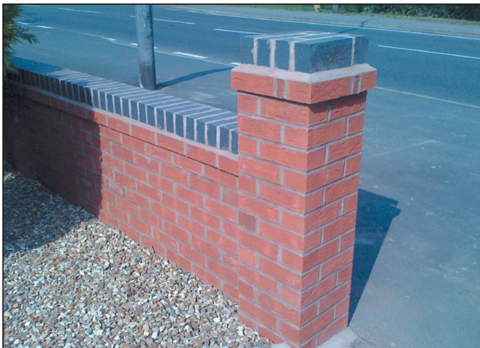
Рис. 236 Примыкающий пилястр, выведенный выше стены.
