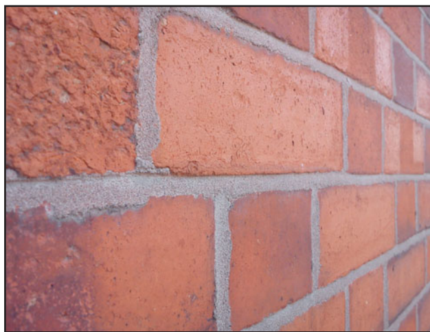
Рис. 161 Выполнение шва, защищенного от погодных факторов.
