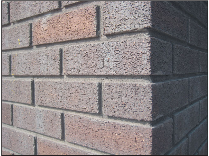
Рис. 157 Выполнение «пустошовки».
