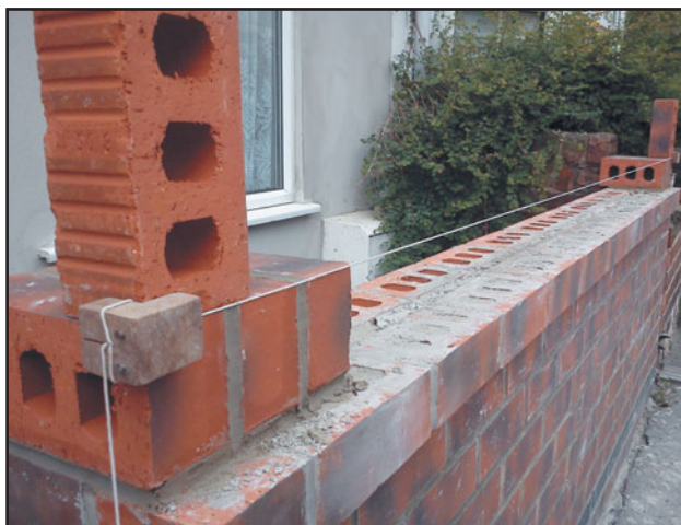
Рис. 210 В каждом конце положены по три кирпича и прикреплен шнур-причалка.
