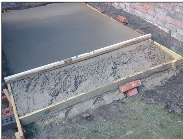
Рис. 47 Простая опалубка для небольшого бетонного фундамента.
