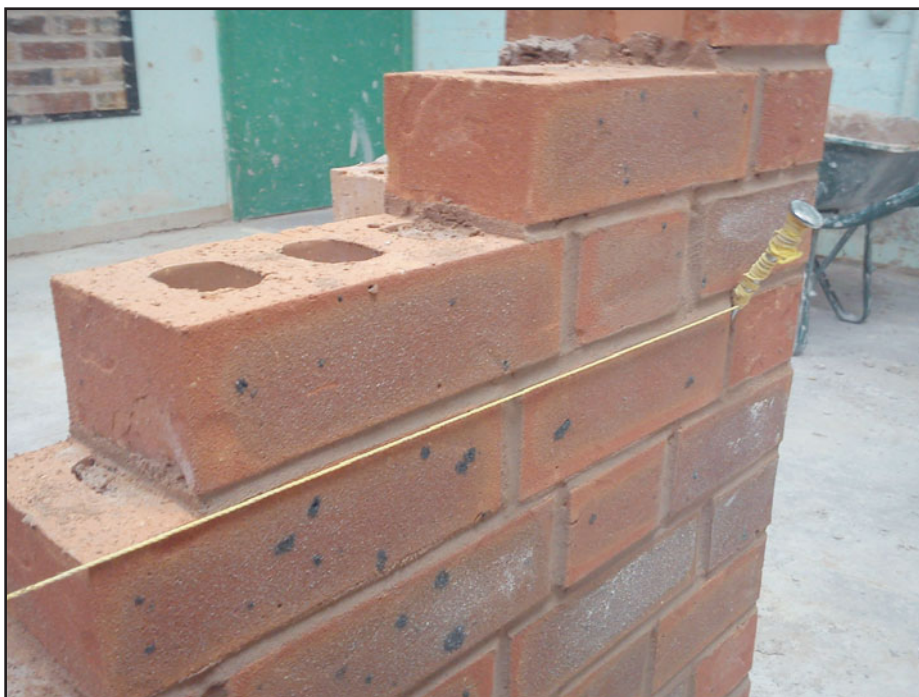
Рис. 134 Использование шнуров-причалок и штырьков.
