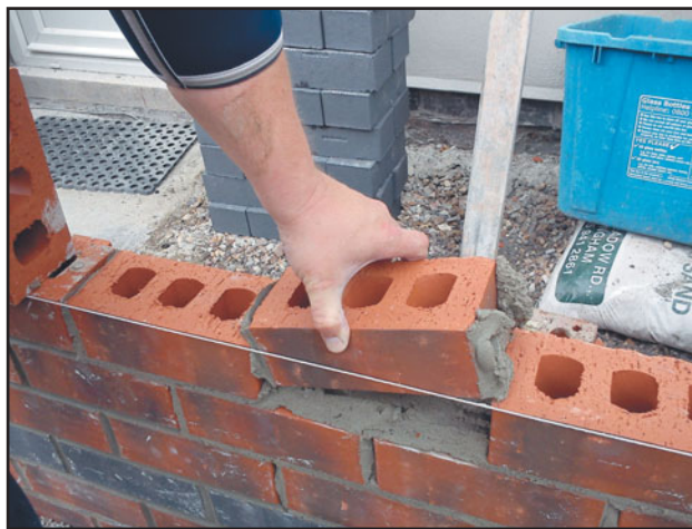
Рис. 141 Укладывание последнего кирпича по шнуру-причалке.
