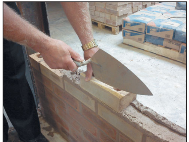
Рис. 115 Укладка кирпича.
