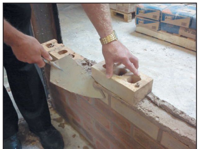
Рис. 116 Срезание излишков постельного слоя.
