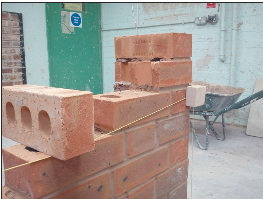
Рис. 137 «Прижимание» шнура-причалки кирпичом без раствора.
