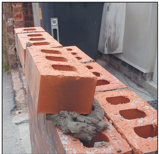
Рис. 221 Выступающий кирпич, вначале уложенный с наклоном в обратную сторону; далее он будет выровнен по ширине.
