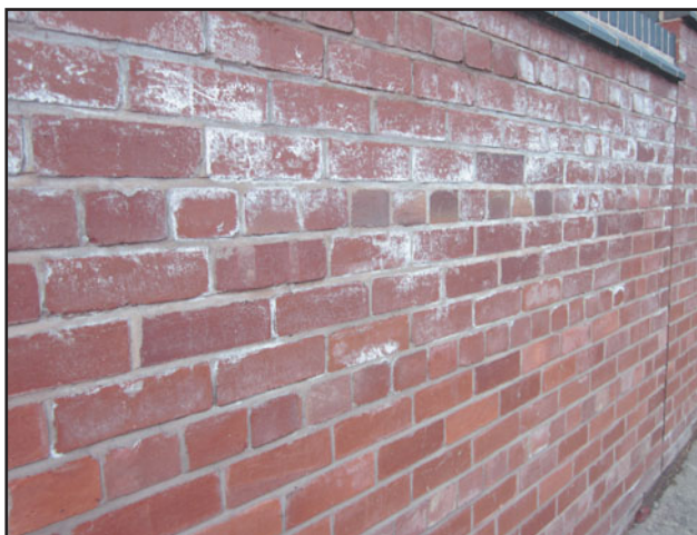
Рис. 264 Высаливание.
