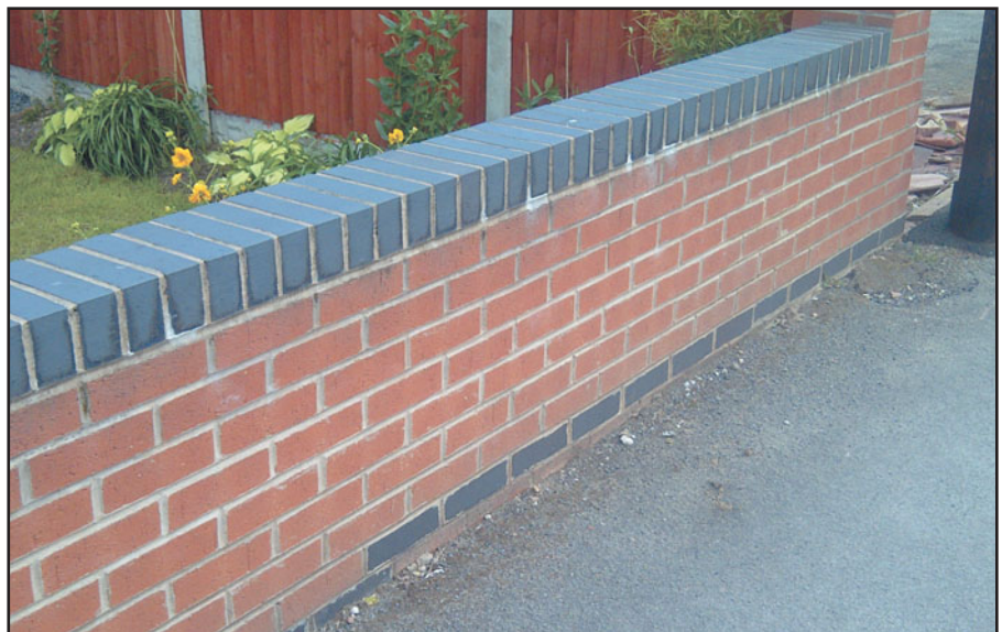
Рис. 207 Простые гребни граничных стен.
