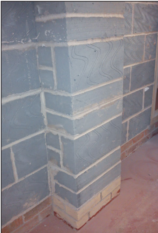
Рис. 104 Пилястр в блочной кладке.
