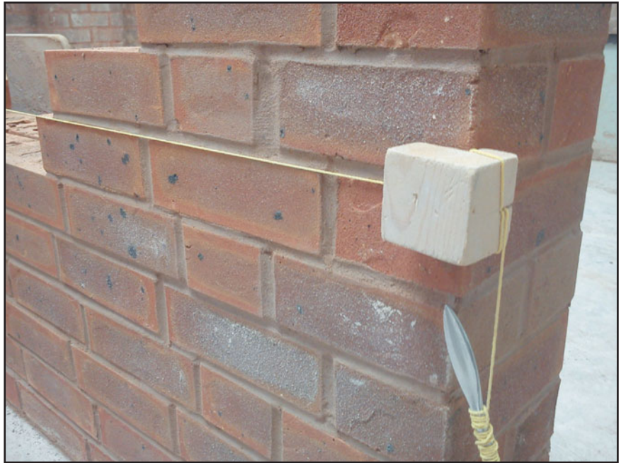
Рис. 135 Использование шнуров-причалок и угловых блоков.
