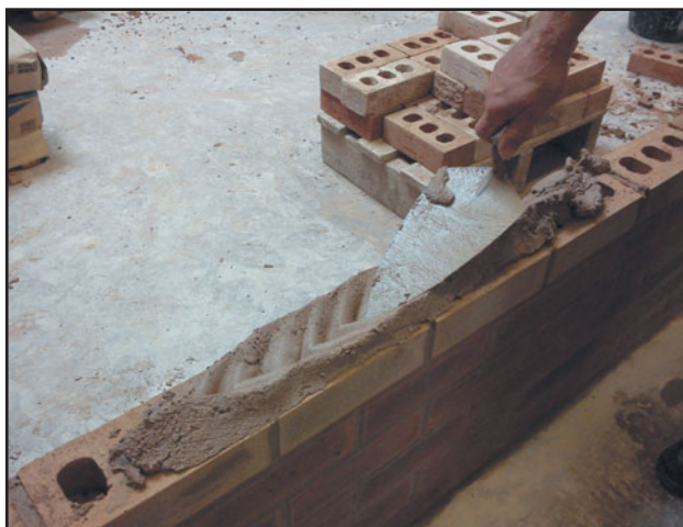
Рис. 113 Расстиление строительного раствора.
