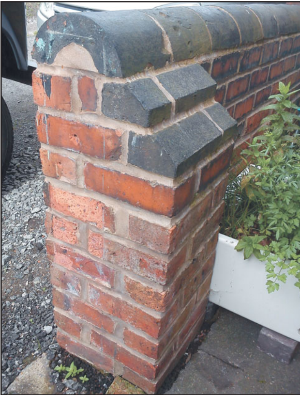
Рис. 234 Пиястр ниже старой стены с фасонными кирпичами для образования «опрокидывания».
