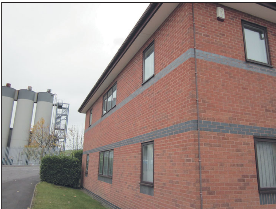
Рис. 248 Кладка стены с отличающимися по цвету полосами из кирпичей различного цвета.
