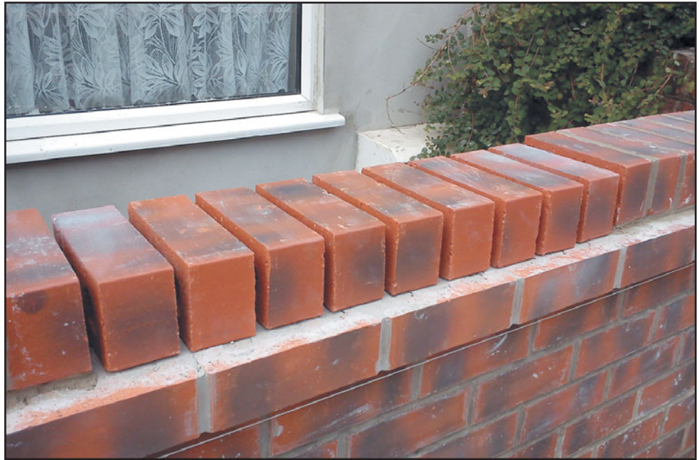
Рис. 211 Планировка центральной части гребня из уложенных на ребро кирпичей выполняется с помощью «сухой раскладки».
