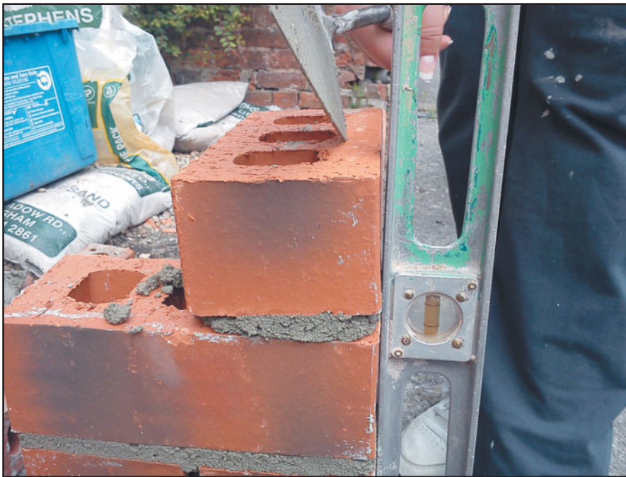
слева: Рис. 130 Выравнивание углового кирпича по вертика- ли.
