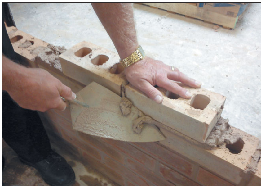
Рис. 121 Укладка следующего кирпича.
