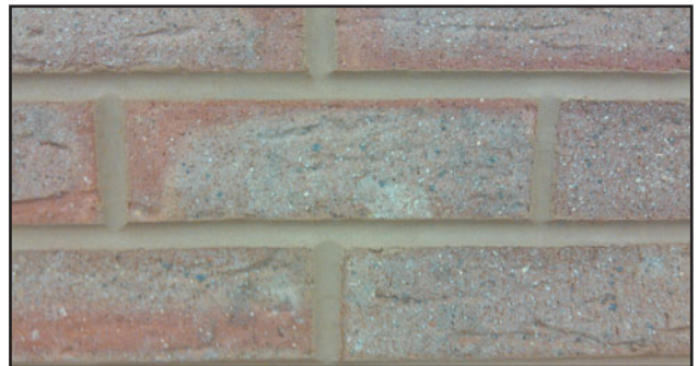
Рис. 154 Завершающая обработка полукруглым вогнутым швом.
