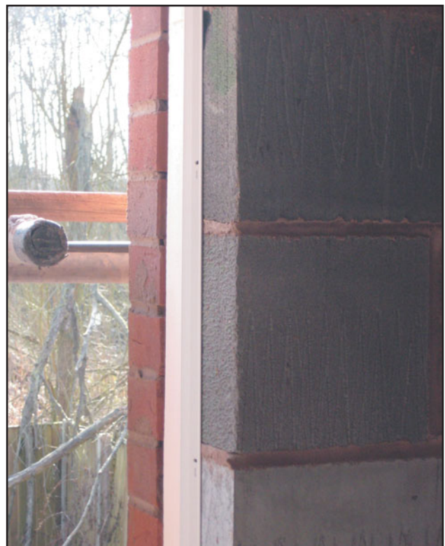
Рис. 184 Изолирующая заглушка полости, установленная у оконного откоса проема.
