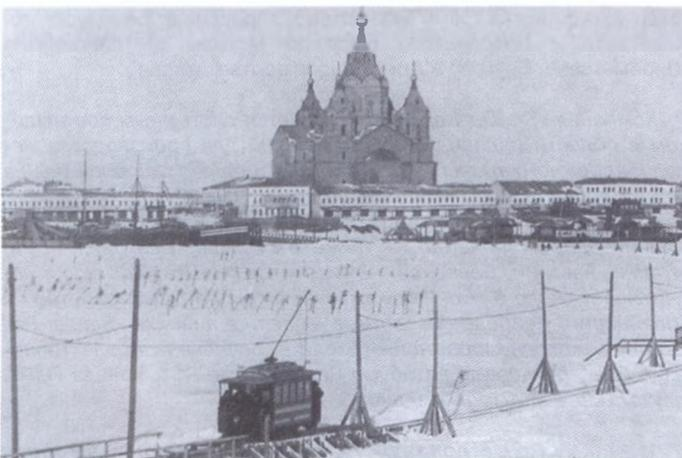
Рис. 3. Пути и первая контактная сеть перекинута по льду Невы от берега до берега
