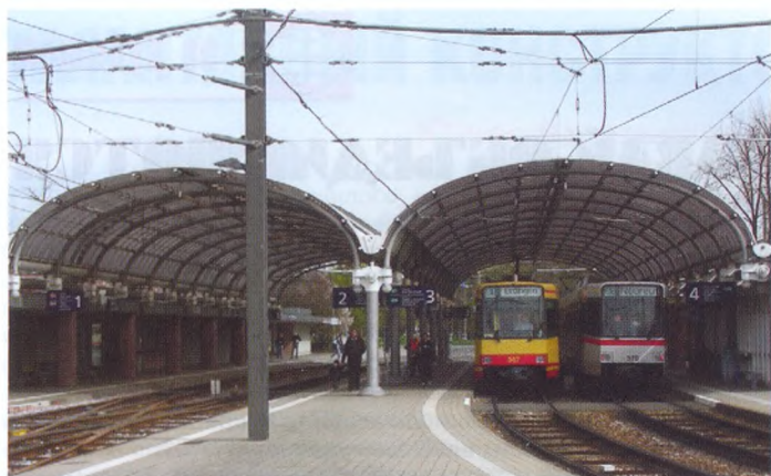
Рис. 3. Станция на переходе с трамвайных линий на магистральные железнодорожные пути
