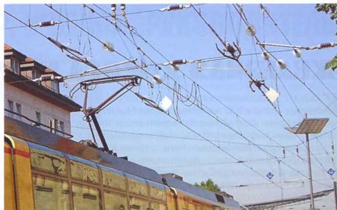
Рис. 4. Двухсистемный электропоезд проходит нейтральную вставку в пункте смены систем электроснабжения
