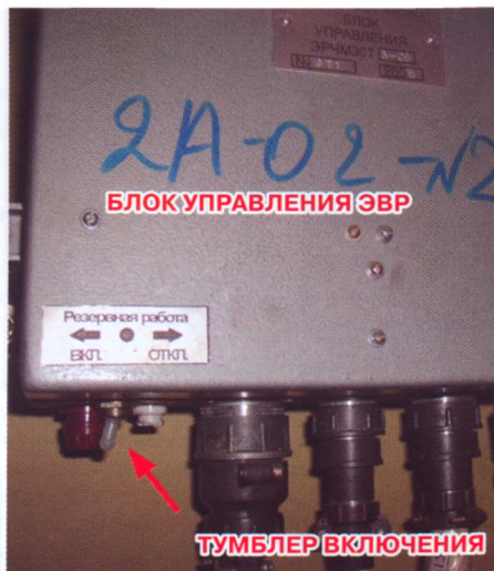
Рис. 7. Тумблер «Резервная работа» на блоке управления ЭВР
