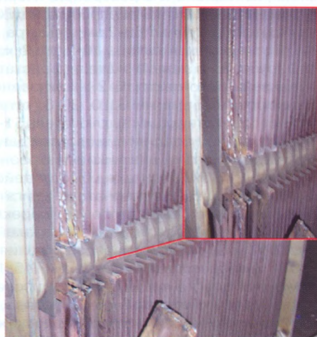
Рис. 3. Перегрев и обрыв секции пускотормозного резистора электровоза ЧС7
