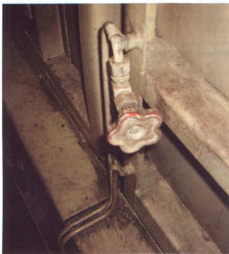
Рис. 3. Вентиль удаления воздуха из топливной системы
