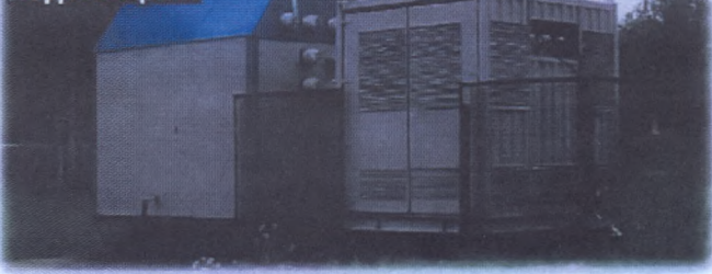
применение устройств автоматического регулирования напряжения на тяговых подстанциях
