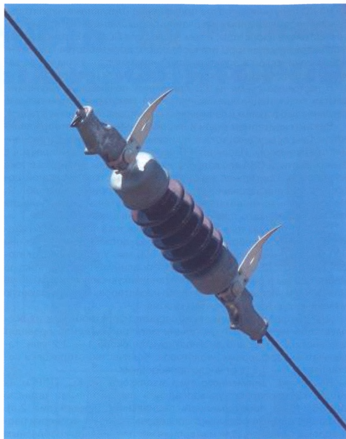
Рис. 3. Защита изолятора от перекрытия птицами
