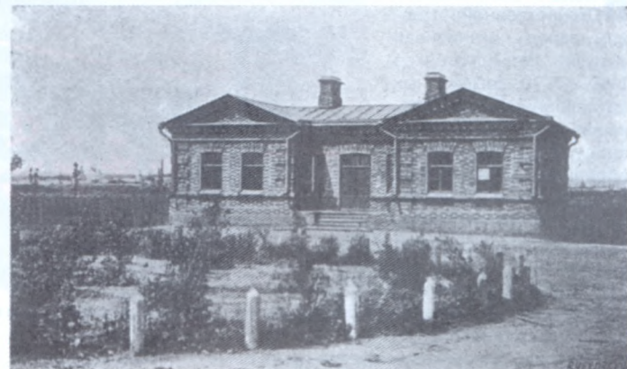
Приемный покой на ст. Острогожск
