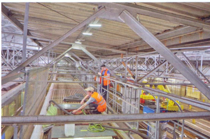
Участок по обслуживанию и ремонту системы кондиционирования электропоездов «Русич»
