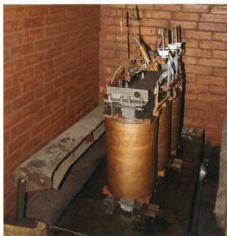
Рис. 1. Так раньше сушили трансформаторы
