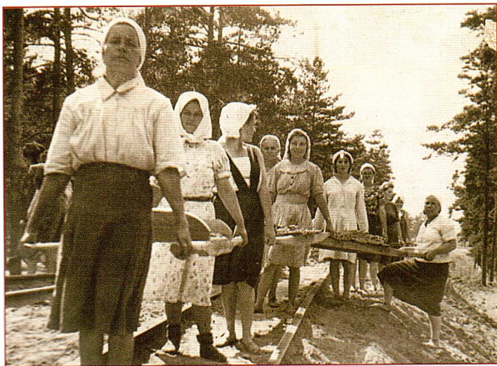
1949 г. Ремонт земляного полотна — это очень просто
