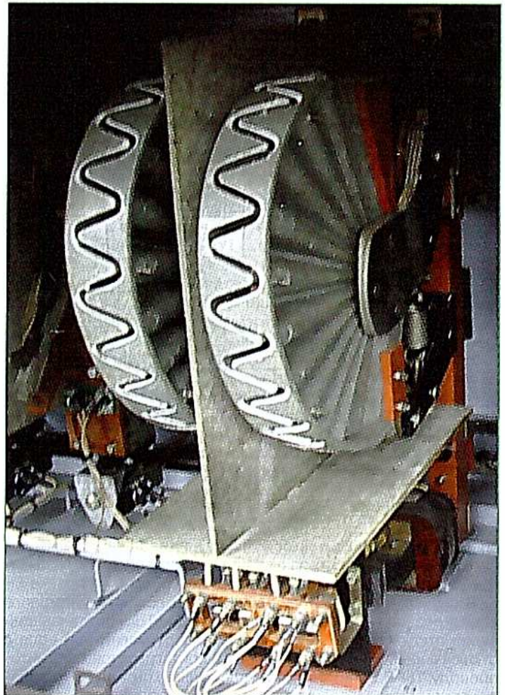
Рис. 2. Быстродействующий контактор КМБ-3
