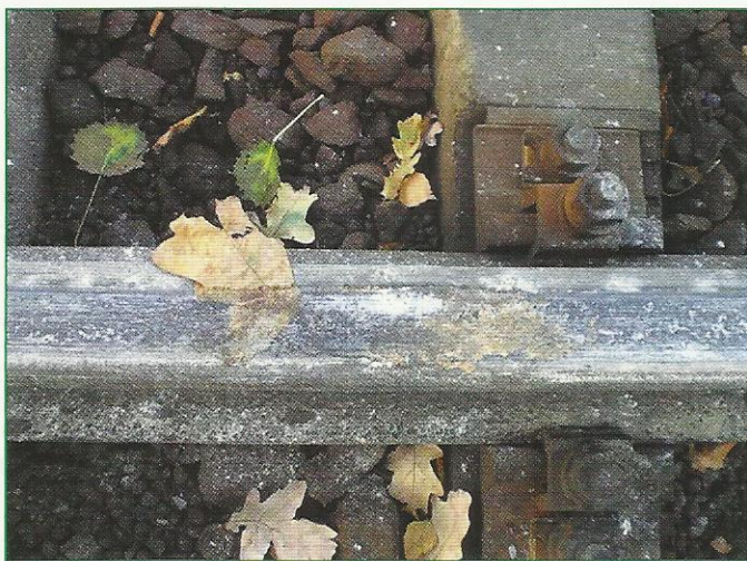
Рис. 1. На поверхности головок рельса раскатаны опавшие листья
