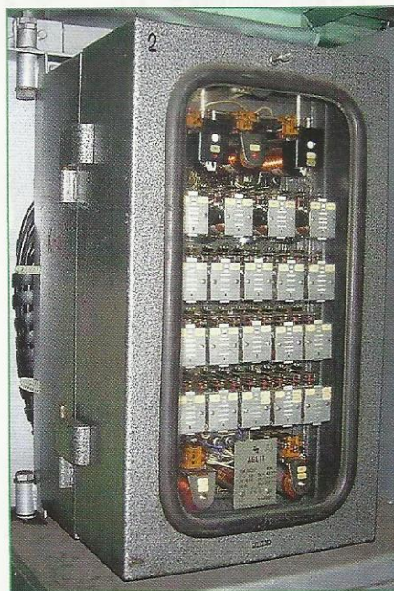
Рис. 1. Общий вид блока защит АГЛ11
