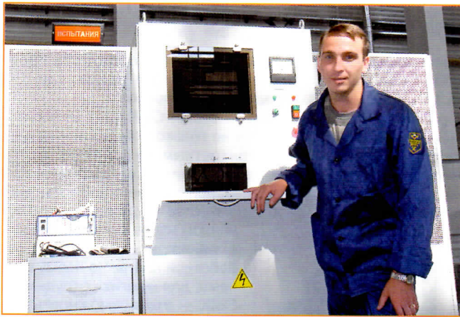
Пост высоковольтных испытаний позволяет проверять прочность изоляции постоянным и переменным током напряжением до 10 кВ. В его разработке принимал участие специалист НИИТКД С.В. Елисеев
