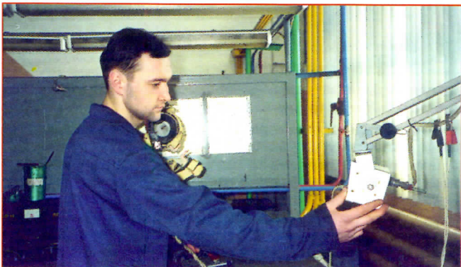
Слесарь-электрик Д.Ю. Карташов проверяет надежность пневматических контакторов после ремонта
