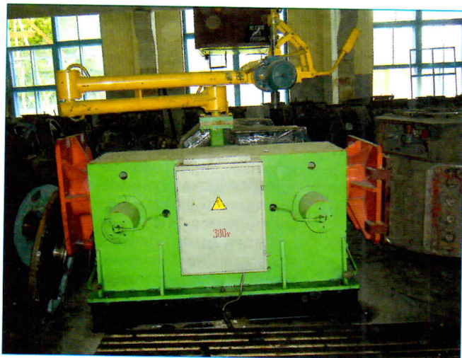
Рис. 3. Технологическая позиция ремонта тяговых двигателей НБ-520В
