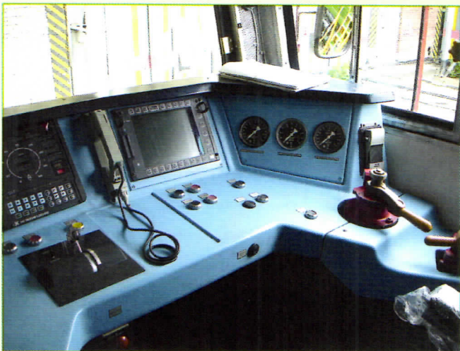
Новый пульт управления тепловоза 2ТЭ10, устанавливаемый при КРП на Уссурийском тепловозоремонтном заводе
