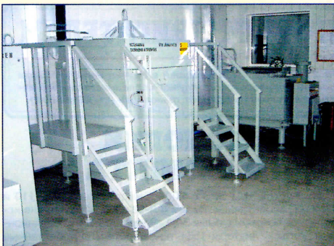
Ультразвуковая установка мойки и пропитки якорей тяговых двигателей ЭД-118 тепловозов ТЭ10
