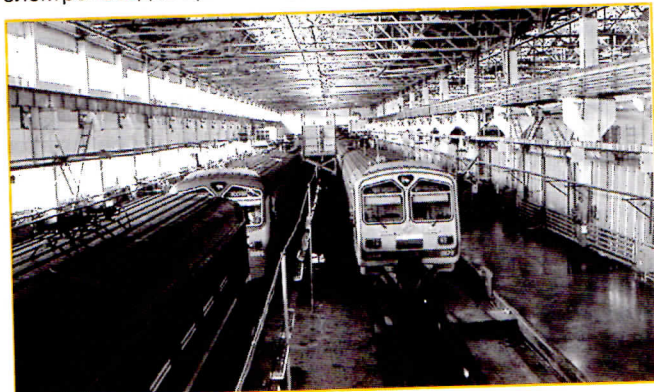
В цехе технического обслуживания и текущего ремонта электропоездов провели реконструкцию
