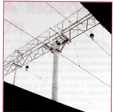
Рис. 5. Ригели жестких поперечин на консольных столиках с двухсторонним опиранием на опоре МТП из трубы \varnothing 299 мм
