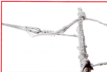
Рис. 2. Узел анкеровки усиливающего провода
