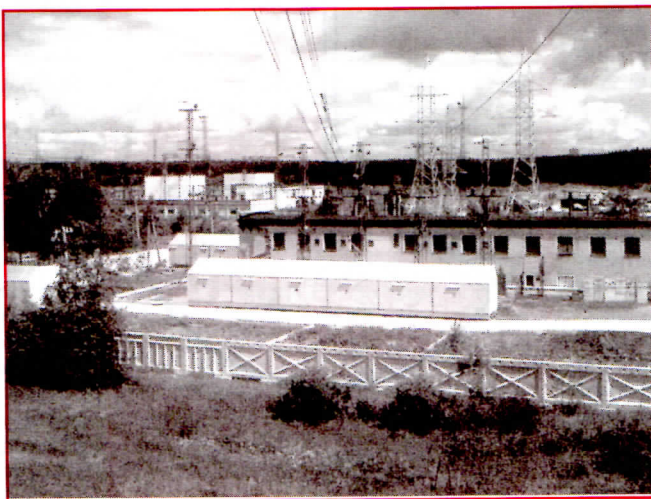
Тяговая подстанция Крюково Октябрьской дороги — одно из самых современных предприятий отраслевой электроэнергетики
