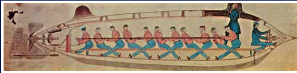
INNENANSICHT DER »HUNLEY«: DER KAPITÄN STEUERT, DIE MATROSEN SITZEN DICHTGEDRÄNGT AN EINER HANDKURBEL UND TREIBEN MIT DIESER DAS U-BOOT AN. EIN WAHRER HÖLLENJOB
