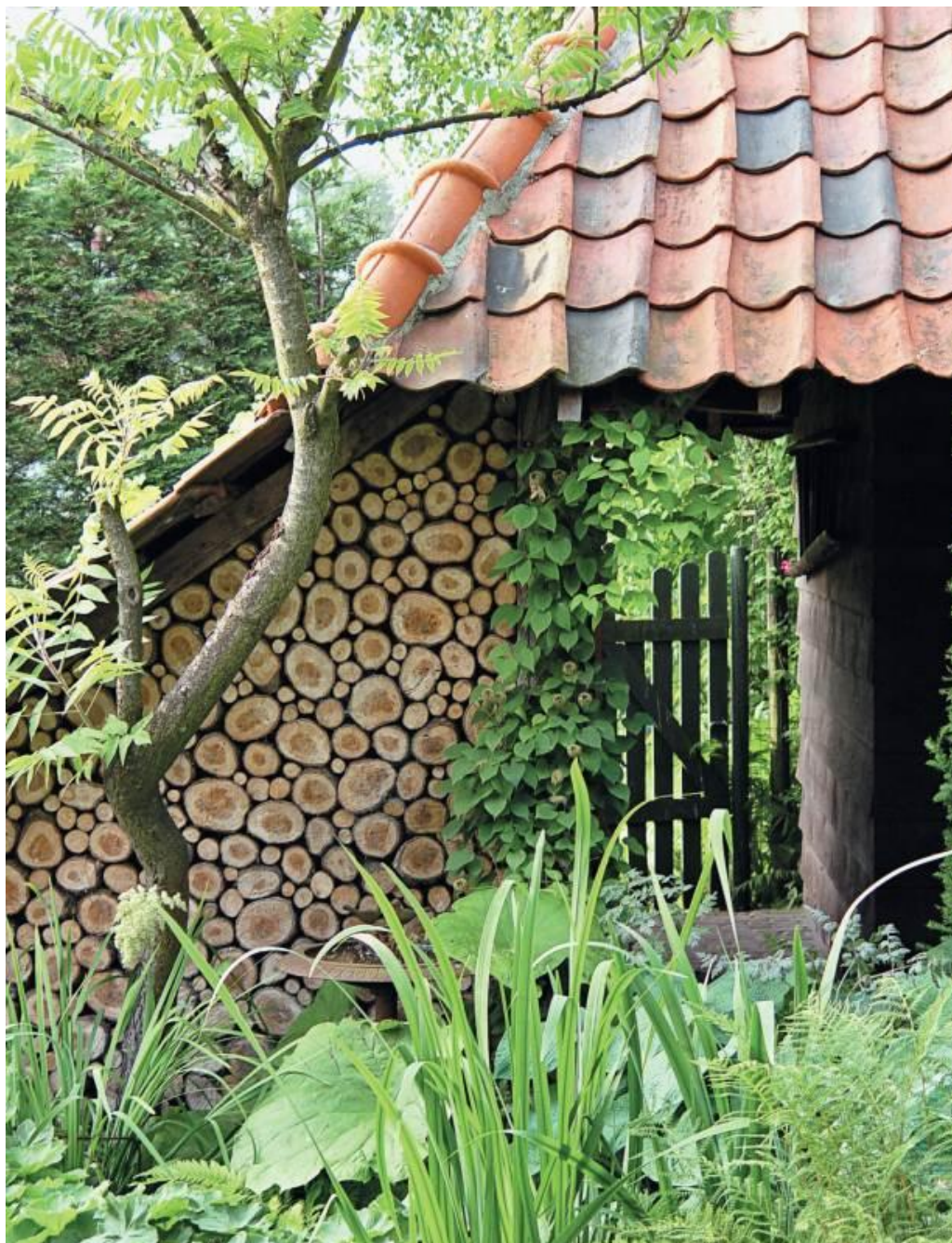
Крыша беседки выполнена из металлической черепицы
