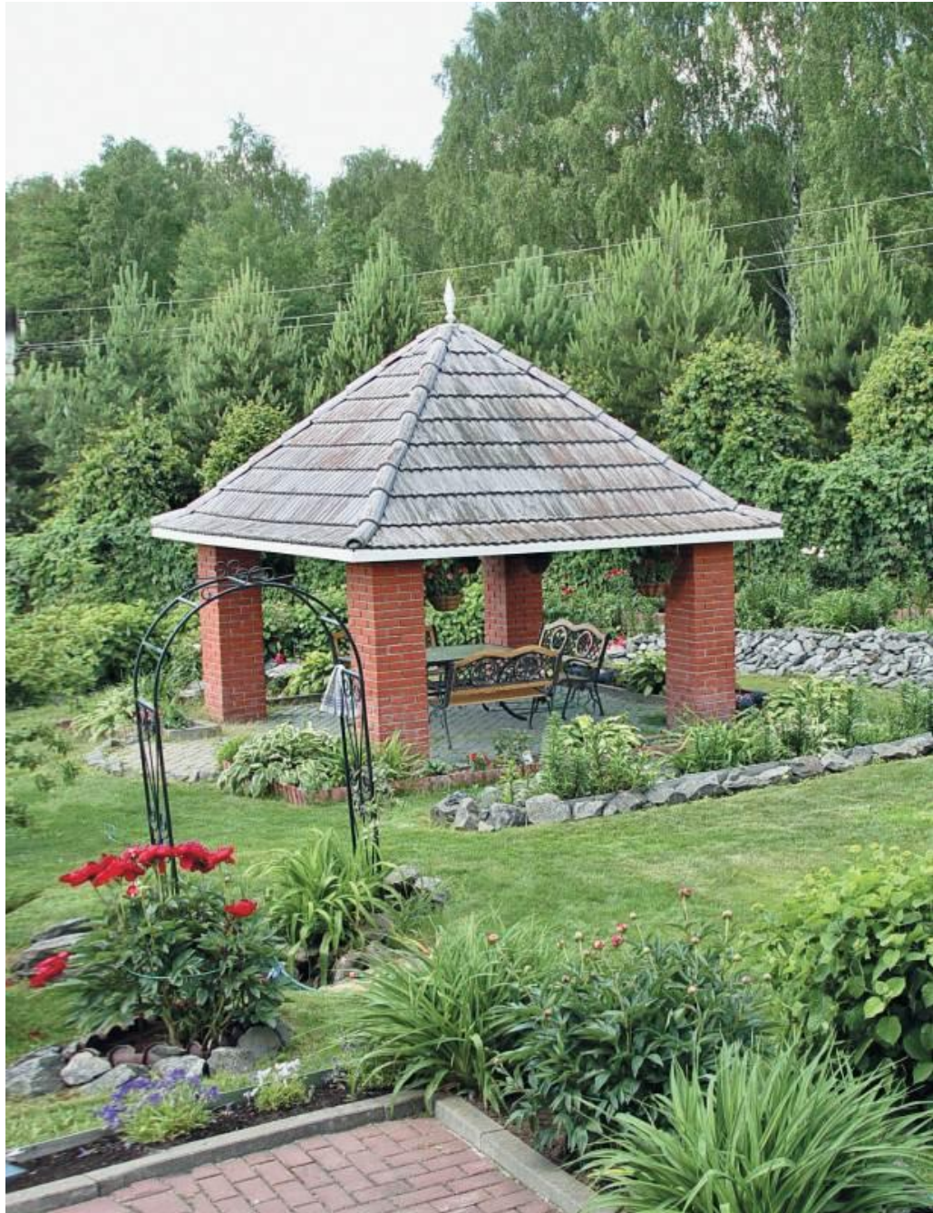
Кирпичные опоры для крыши
